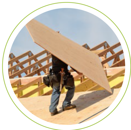
Techumbre, revestimiento de muros y cielos.
