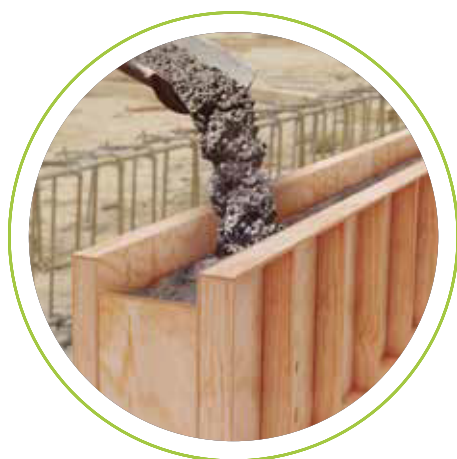
Moldaje de hormigón
