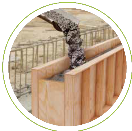
Conformado de hormi gón y base pa ra laminar.
